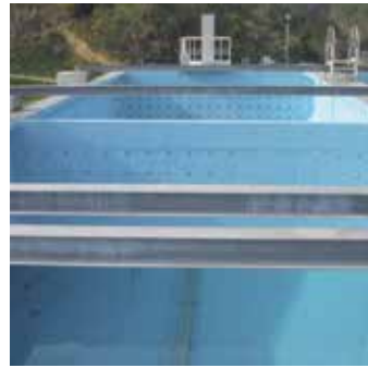
浄水場沈殿池
