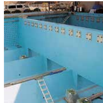
浄水場沈殿池
