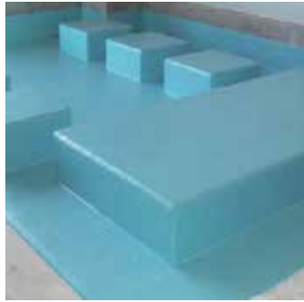
薬品設備架台
