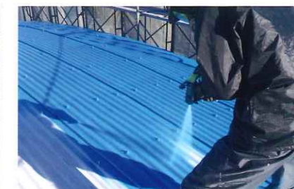
製造工場屋根補強
