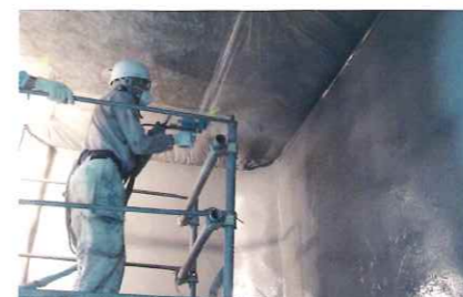
発電所ピット内面
