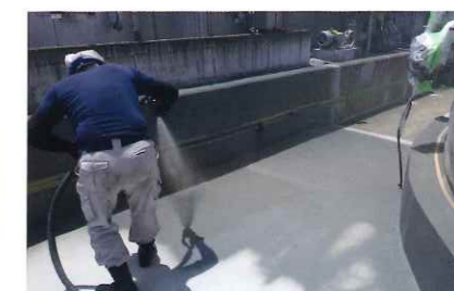
化学工場防液堤
