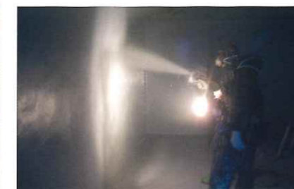
製鉄所排酸槽内面
