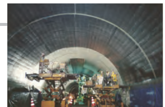
トンネルへの施工例
