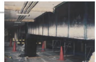
梁への施工例
