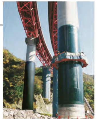
橋脚への施工例
