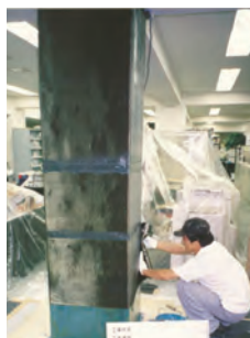
独立柱への施工例
