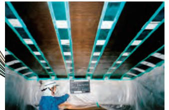
床版への施工例
