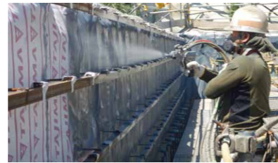
先やり工法施工例
