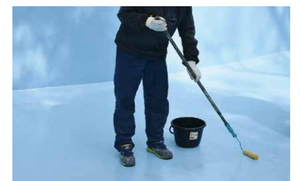
UAコートクリア塗布作業
