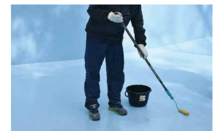
UAコートクリア塗布作業
