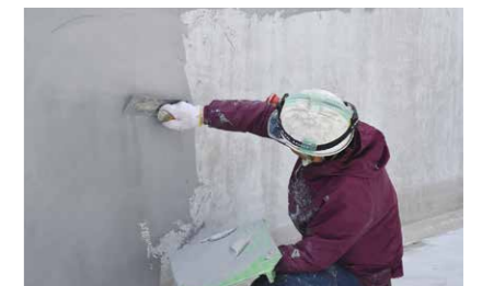
左官ゴテによるUAベースE塗布作業
