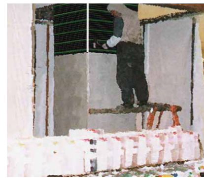
〈柱居〉(居ながら施工)
