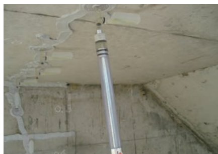
コンクリート打放し・上裏面
