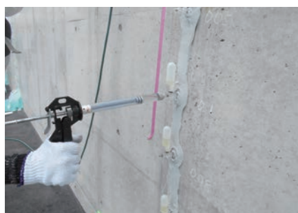
コンクリート打放し面
