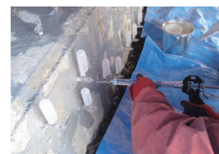
橋台ひび割れ注入
