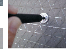
アンカーピン打込み
