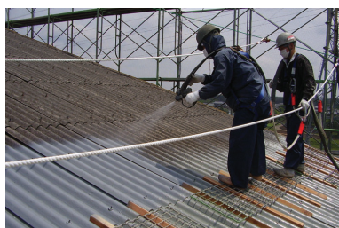
スレート屋根改修
