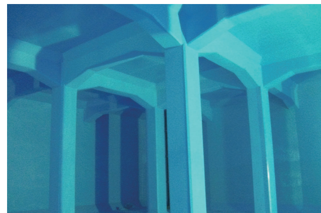
上水施設(配水池)
