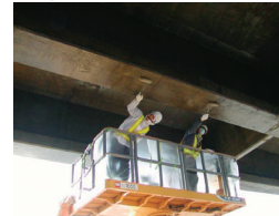
●プライマー塗布
