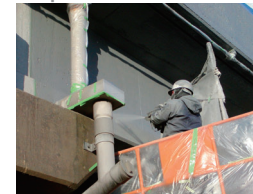
●レジテクト100(R1)吹付け
