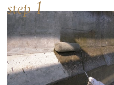
プライマー塗布
